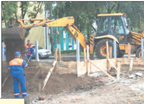
Prace związane z montażem pomnika Prezydenta już trwają
