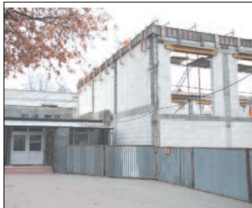
Zdjęcie dokumentuje I etap realizacji inwestycji. W tej chwili trwają prace wewnątrz dobudowanej części.
