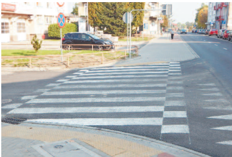
Przejście-przejazd na ulicy Toruńskiej przy skrzyżowaniu z ulicą Staszica
