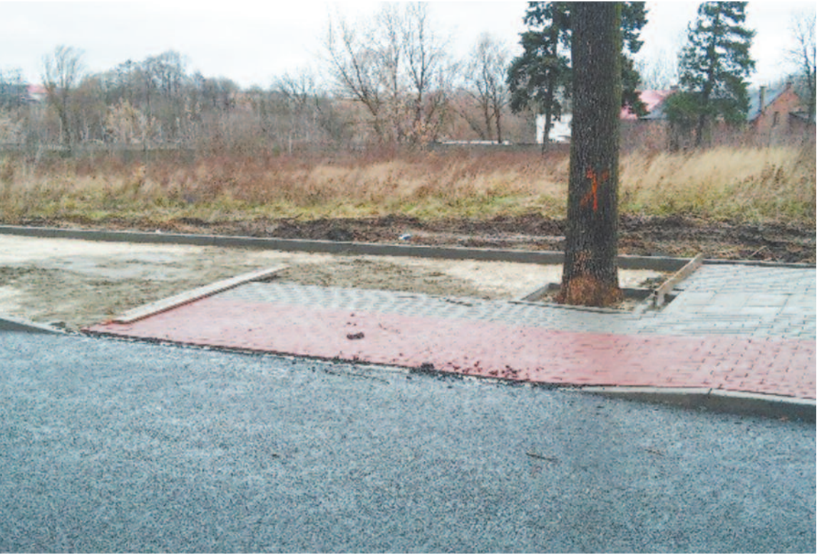
Jedyny poprawnie wykonany zjazd
