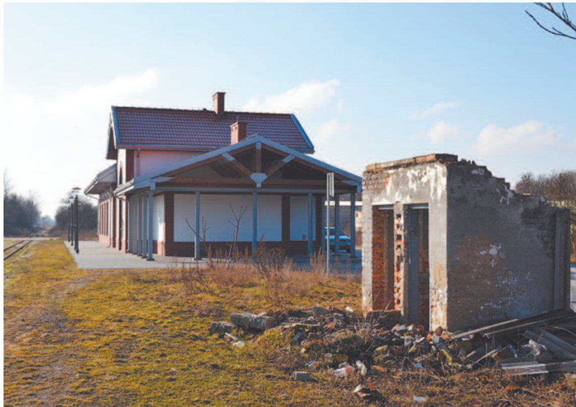
Rozpadająca się ubikacja na tle budynku stacyjnego w Tułowicach (fot. Ł. Popowski).
